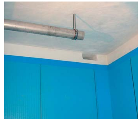
Einblicke in das sanierte Reservoir Spitaler
