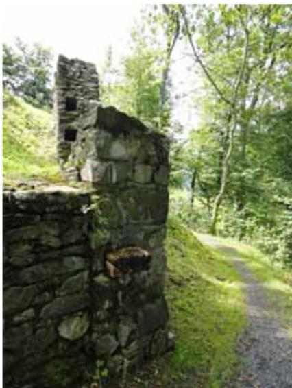
Das Tor zum Vorwerk an der Westecke mit den Schliessbalken.
