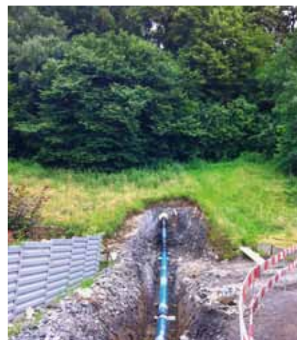
Einführung der Wasserleitung in die Kernbohrung welche auf einer Länge von ca. 50 Metern unter dem Wald hindurch führt.
