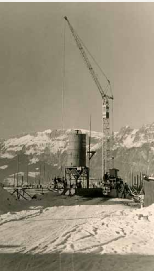
Baustelle mit dem ersten in Schellenberg eingesetzten Baukran im Winter 1960/61.
