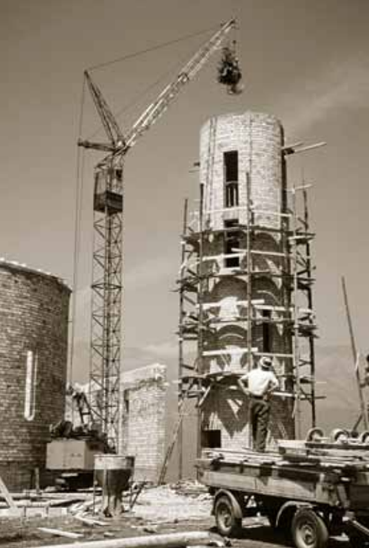
Der Richtbaum wird auf dem Kirchturm montiert. Aufnahme Ende Juni 1961.
