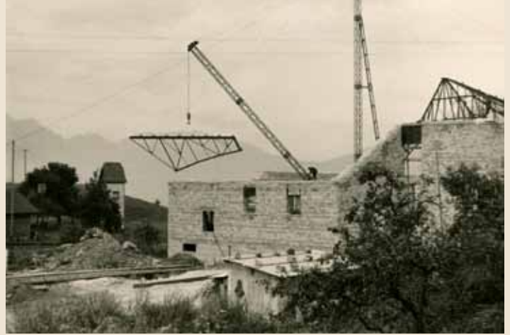
Die Dachkonstruktion aus Stahl wird montiert. Aufnahme September 1961.
