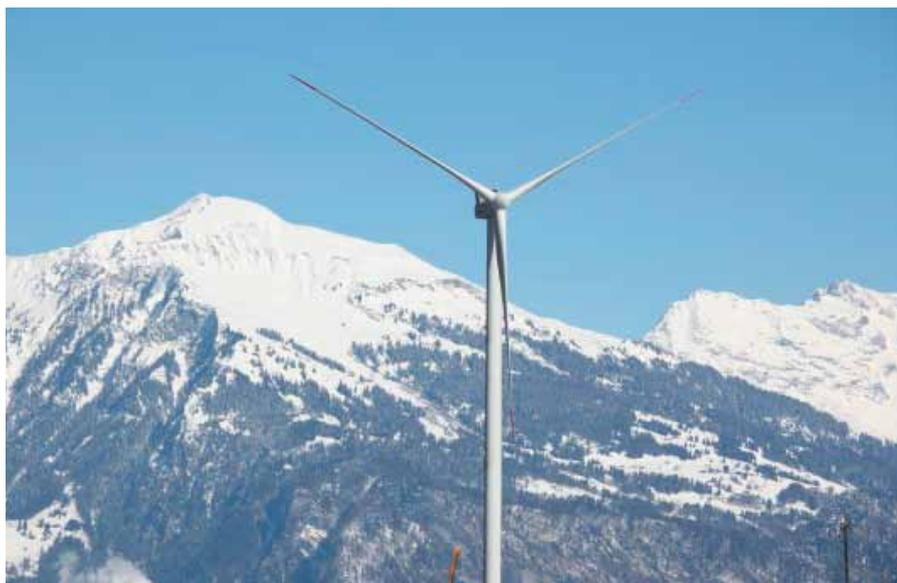
Anlage Vestas V-112 in Haldenstein mit 55 Metern Rotorblattlänge und 3000 Kilowatt maximaler Leistung. Die von den 3 Rotorblättern überstrichene Fläche beträgt mehr als 1 Hektare.
