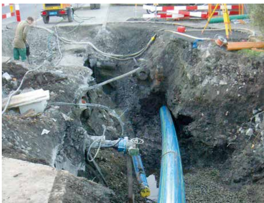
Das Ende der Wasserleitung nach dem Einzug mittels Spülbohrverfahren.
