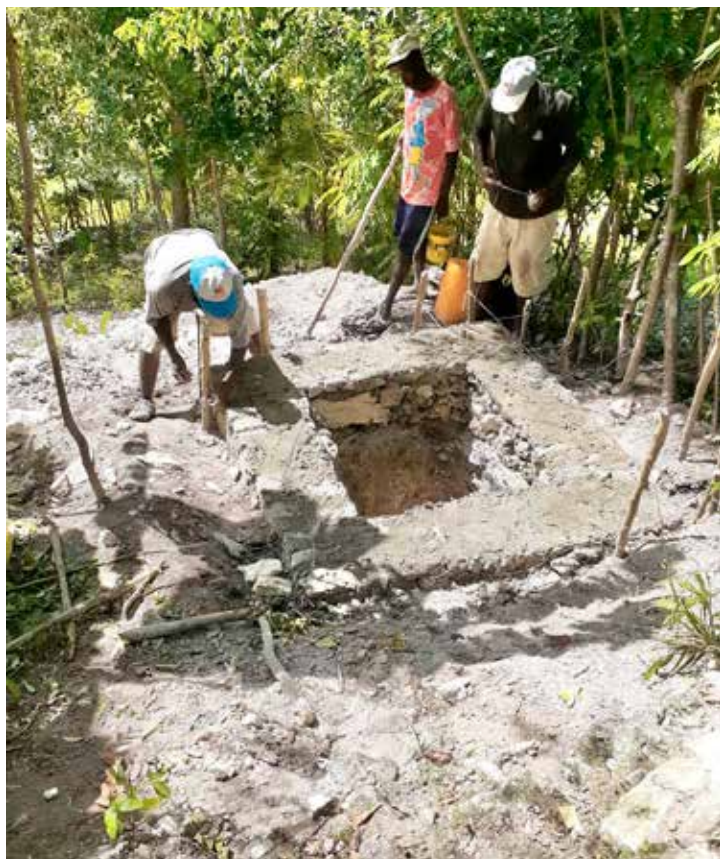
Grube und Fundament der Latrine ist in Bearbeitung.
