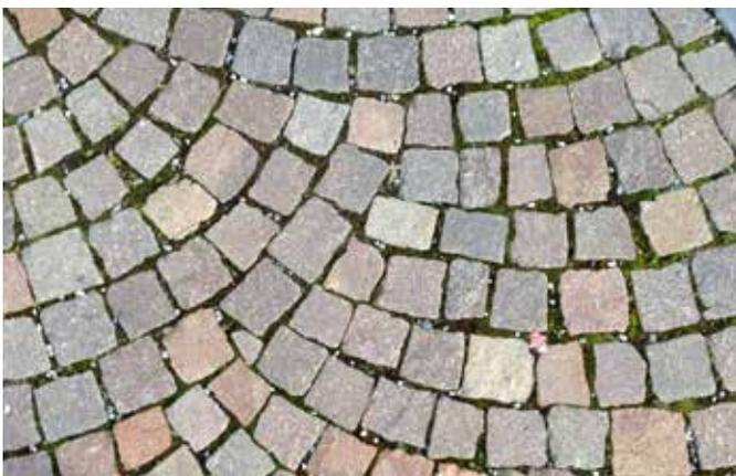
Die eine Pflasterung hat Mörtelfugen und ist für Wasser faktisch undurchlässig (Abflussbeiwert 0.80). Die andere Pflasterung hat Kiesfugen und Wasser kann, zumindest teilweise, versickern (Abflussbeiwert 0.40). Das heisst rechnerisch, dass im einen Fall doppelt so viel Wasser oberflächlich abfliesst wie im anderen.
