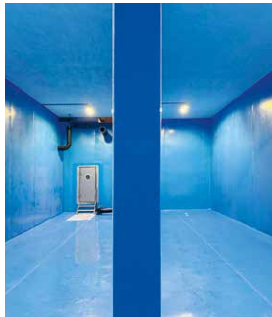
Das im Bau befindliche Reservoir in Schaanwald
