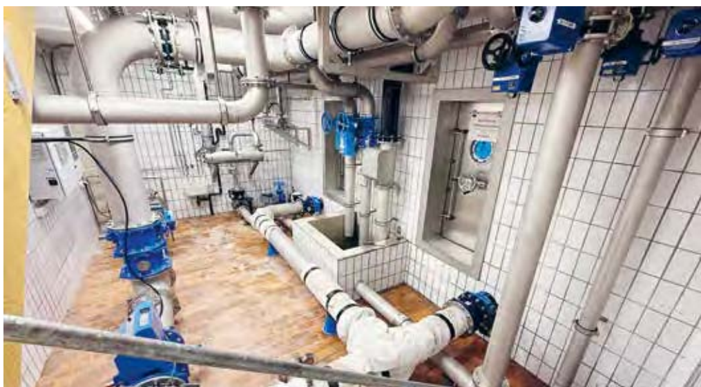
Reservoir Schaanwald: Inbetriebnahme Behälter war im Mai 2025
